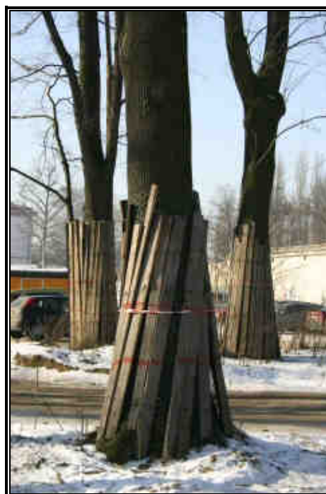
Fot. 10.1 Przykładowy sposób ochrony pnia drzewa przed uszkodzeniem związanym z pracami wykonywanymi w jego pobliżu
