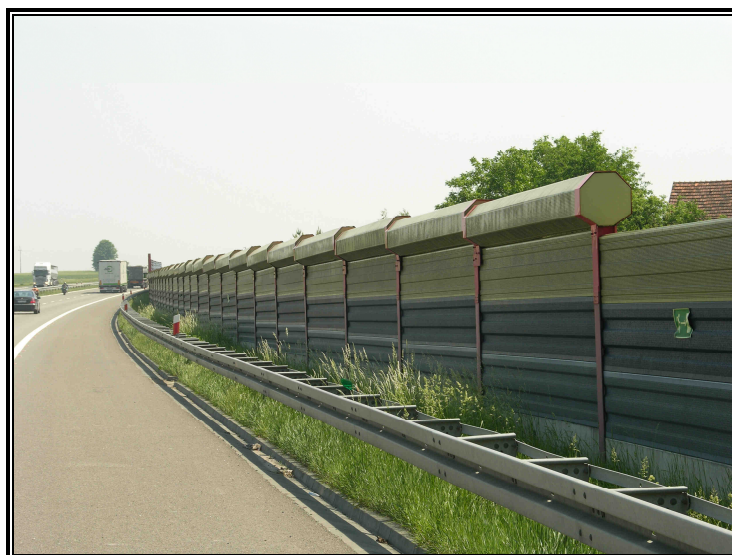
Rys. 10.1 Przykład zastosowania oktagonów na autostradzie A4 w rejonie Opola
